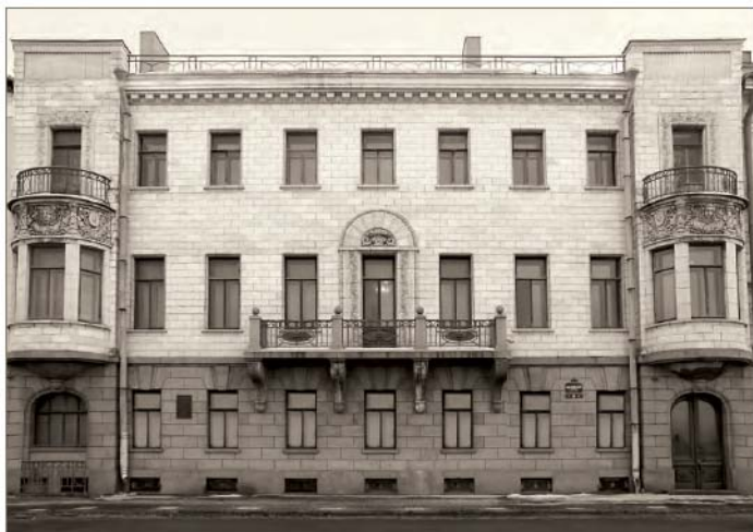
Фасад дворца на Английской набережной дом 54. Дворец представляет собой замкнутую и углубленную «городскую усадьбу» с различными служебными постройками и фасадными домами, обращенными на тыльную сторону, на Галерную улицу
