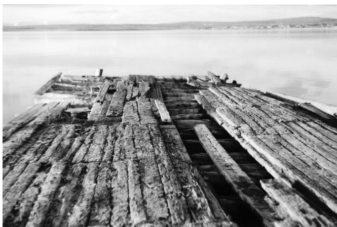
Полуразрушенная пристань в пос. Зашеек
