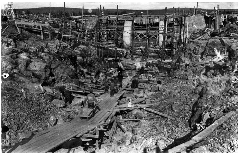
Строительство одной из плотин каскада Нивских ГЭС в 1932 году
