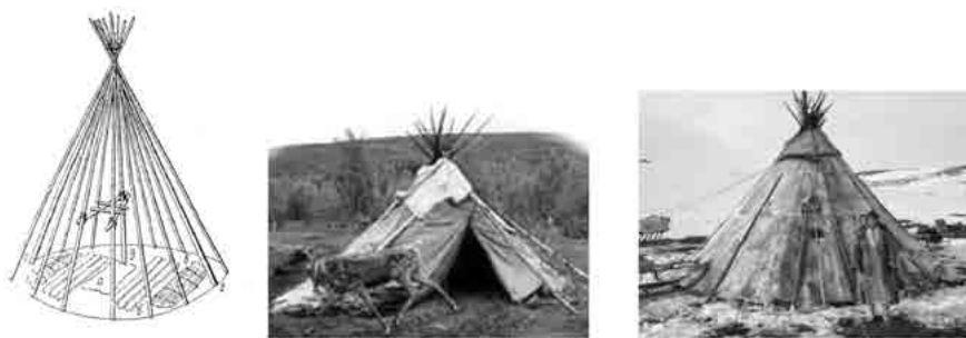
Рис. 1. Схема конструкции и внешний вид: кумаксы (слева) чума (справа)
