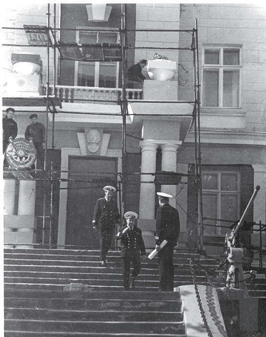
Идут работы по ремонту здания штаба. Фото 1985 года
