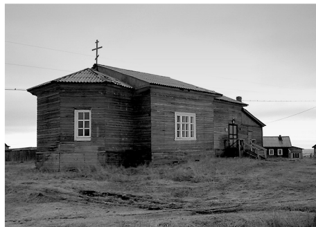
Здание Тихвинской церкви перед началом реставрации. 2007 год
